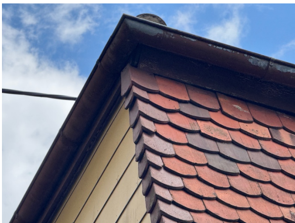
Abb. 4: Übergang zwischen Walmdach und Giebelwand mit potentiellen Spaltenquartieren.
